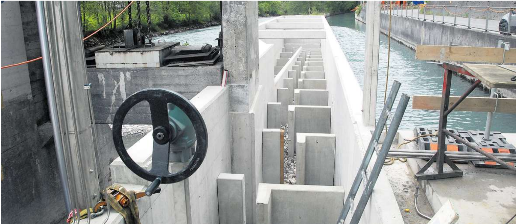
Fischgerecht: Beim Kraftwerk Elggis in Netstal wird derzeit eine Fischstappe gebaut.
