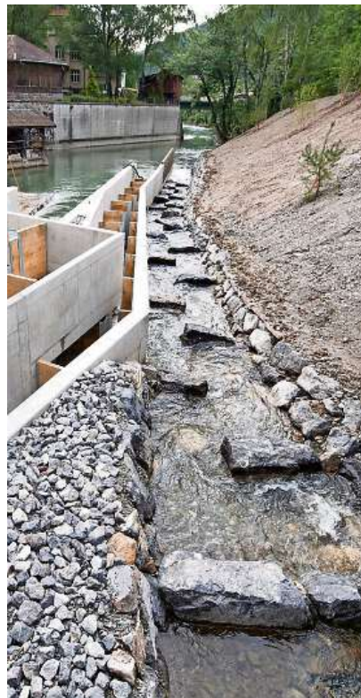
Umleitung: Die Fischstufe in Ziegelbrücke – hier während des Baus 2011 – wird inzwischen von den Seeforellen gut genutzt.
