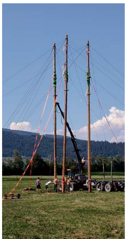
Von Weitem zu sehen: Die Masten des grossen «Sarasanis»-Blachenzelts stehen bereits.
